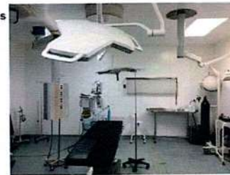
Equipo descompuesto y obsoleto
