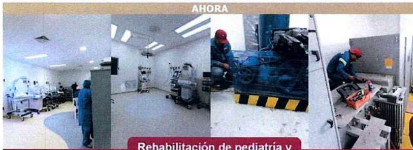
Rehabilitación de pediatría y tococirugía
